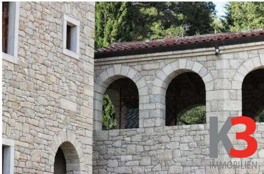
Das Gebäude besteht vollständig aus handbehauenen Stein, die Außenwände sind doppelt: von außen nach innen Stein (ca. 30 cm), dann in Stahlbeton gegossen, Dämmung aus Styropor und Ziegelstein (25 cm).
